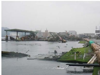
写真1 震災で地盤沈下した気仙沼魚市場
